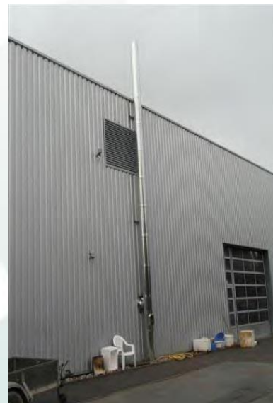
Ansaugung von Frischluft durch einen zentralen Kanal mit einer Zuluft durch ein Gitter in der Außenwand.
