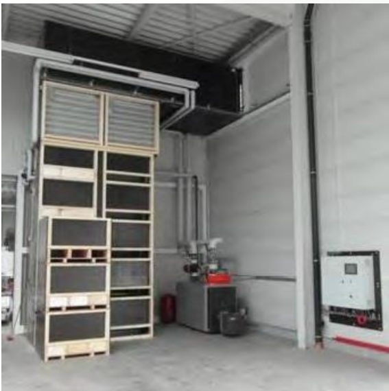
Übersicht über die Trocknungsanlage für zwei Abschnitte mit Zentralheizung.
