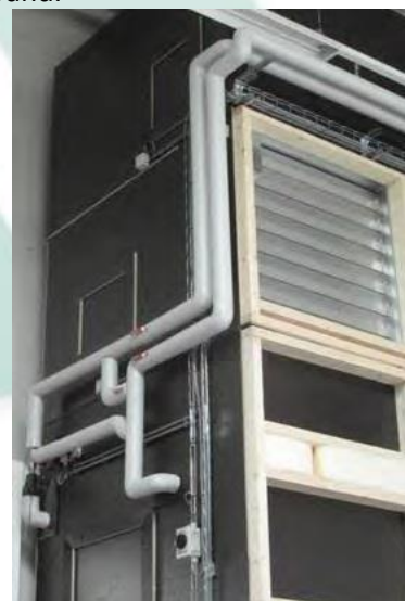
Verbindung von Rohren mit dem Heizkörper im Luftverteilsystem.
