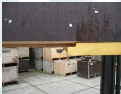
Unterschiedliche Stärke der Multiplex-Platte und der Hartholzplatte.
