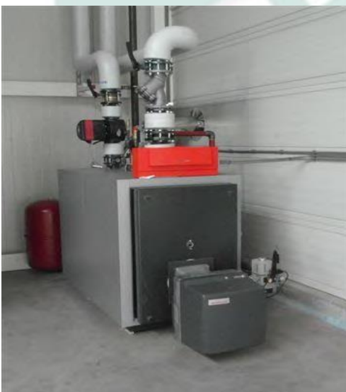
Beispiel eines Boilers für die Zentralheizung von zwei Abschnitten.
