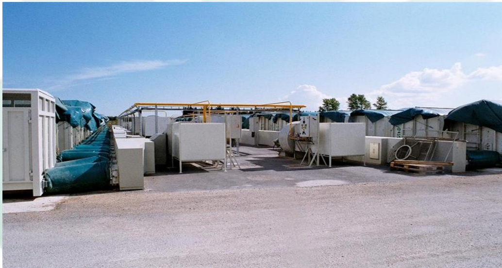
Sezione d'essiccazione con ventilatore, canale di ripartizione aria e collegamenti con i container
