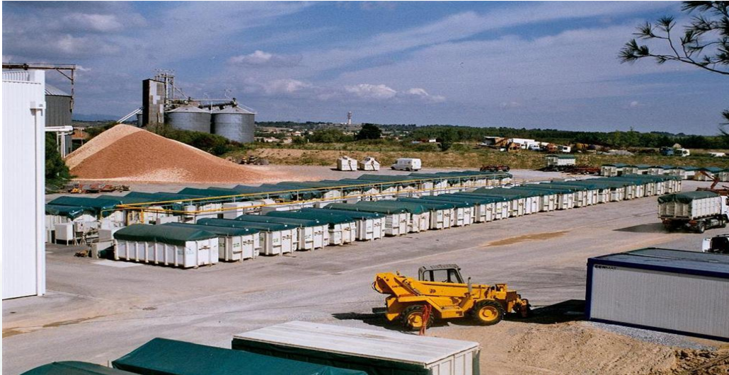
Visione d'insieme degli impianti d'essiccazione con container
