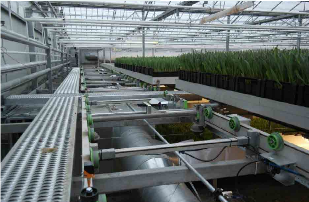
Boven in de kas buizenverwarming en schermdoek. Daar onder de LBK's en luchtzakken voor een tussenlaag.
