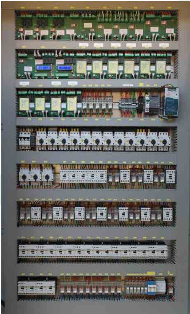
Voorbeeld schakelkast met relais en ABC printen
