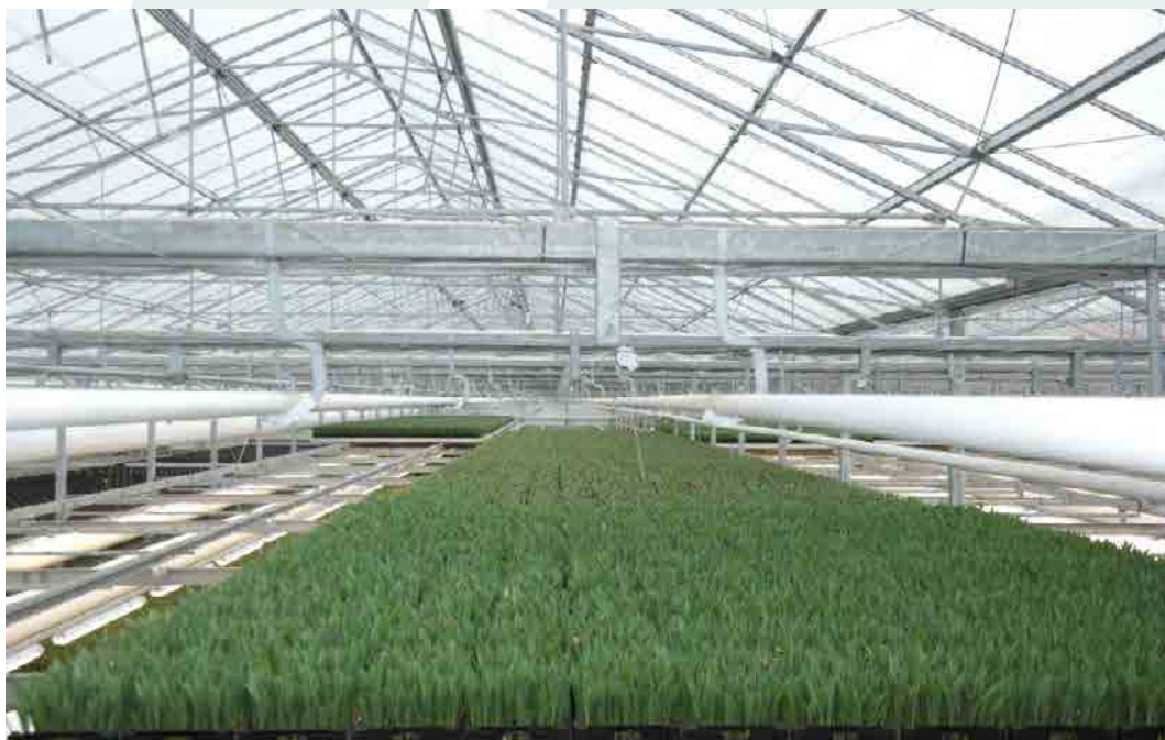
Inrichting van de bovenste teeltlaag (fase 2) met buizensysteem, schermdoek en ramen.
