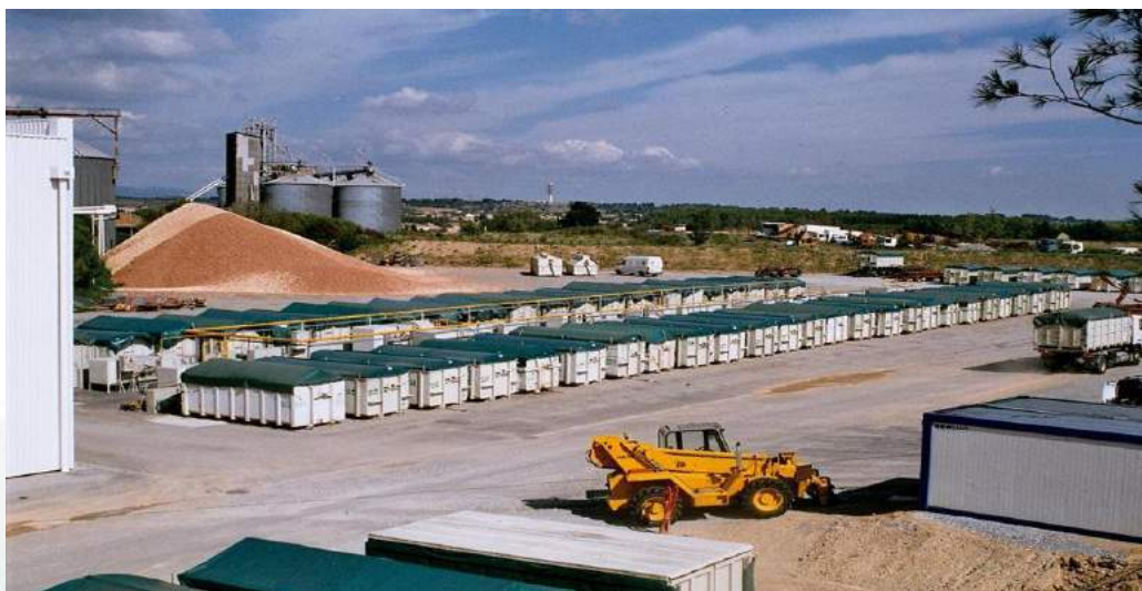
Vista de instalaciones de secado con contenedores
