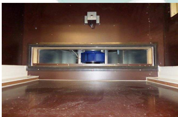
El ventilador de alta presión con sensor de flujo para cada sitio de caja.
