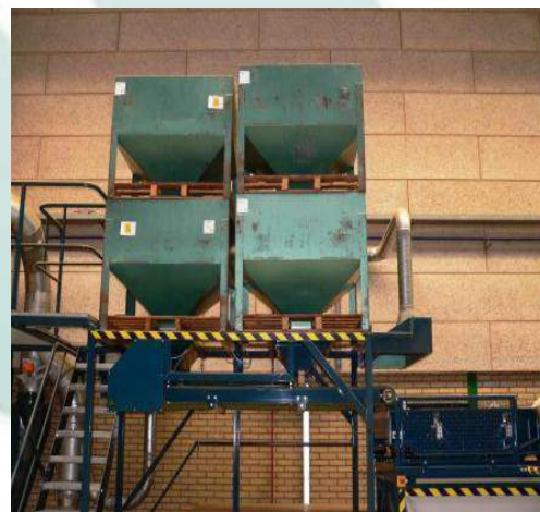
Los silos de tolva en la parte superior dosifican las semillas a los silos de tolva más abajo. Desde aquí, las semillas serán transportadas por una correa hasta la calibradora de pantalla plana.
