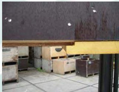
Verschil in dikte van het multiplex en de hardhouten plank.
