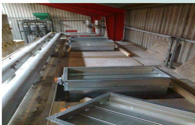
Bovenkant van een bestaande drooginstallatie; installatie van kleppenregisters voor gedroogde lucht.
