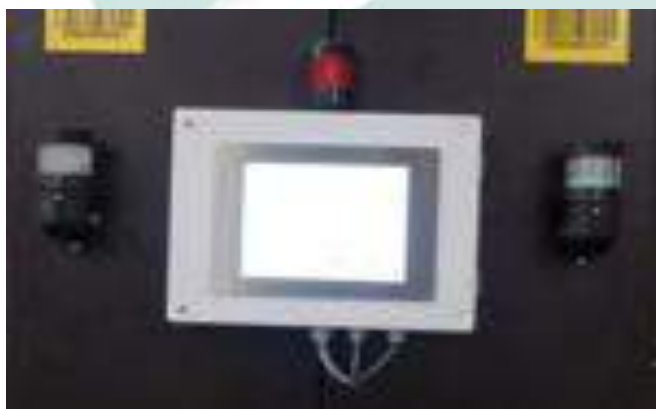
Het proces kan worden ingesteld en gecontroleerd via een paneel met touchscreen en ABC Software.
