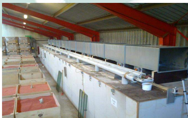
Lucht-verdeelkanaal boven op de kleppenregisters. Gedroogde lucht uit de luchtdroger naar elke sectie.
