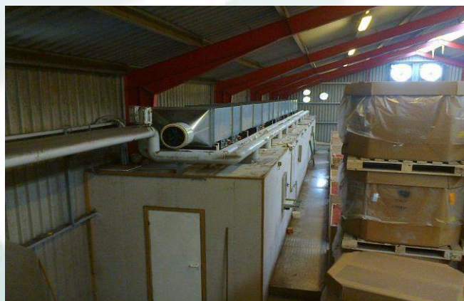
Drooginstallatie na aanpassing; een centraal kanaal met per rij/sectie een kleppenregister.
