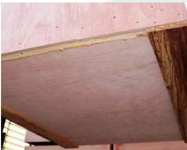
Kistbodem wordt afgesloten met 9mm multiplex.
