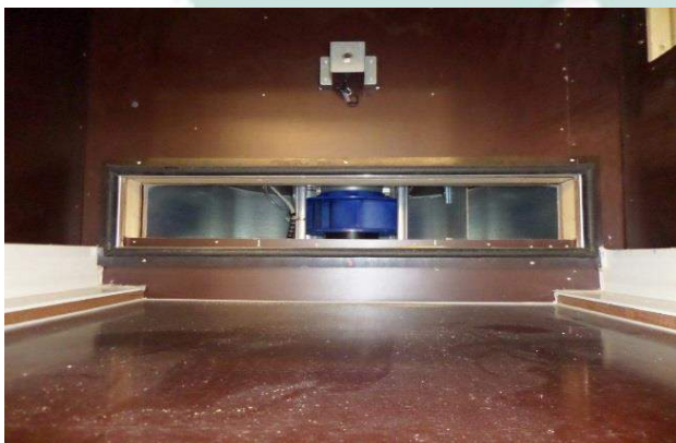
Hoge druk ventilator met 'flow sensor' voor elke kistplaats.
