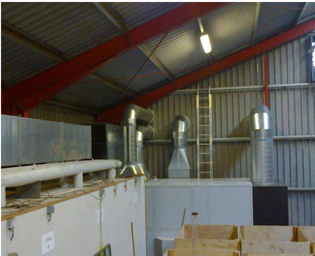
De centrale luchtdroger wordt aangesloten op het luchtkanaal.
