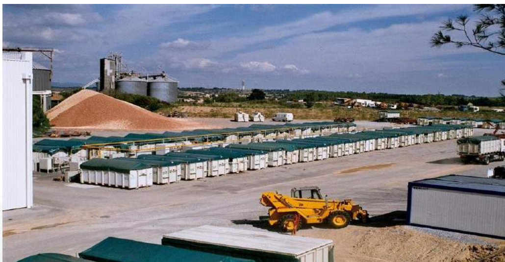
Overzicht drooginstallaties met containers
