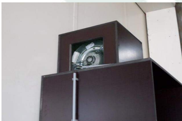
Centrifugaal ventilator om geconditioneerde lucht op te nemen en door het zaad te blazen.
