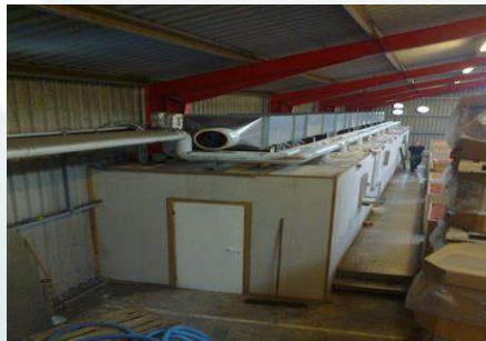
Nieuw luchtkanaal voor verdelen van de gedroogde lucht naar de verschillende droogsecties.
