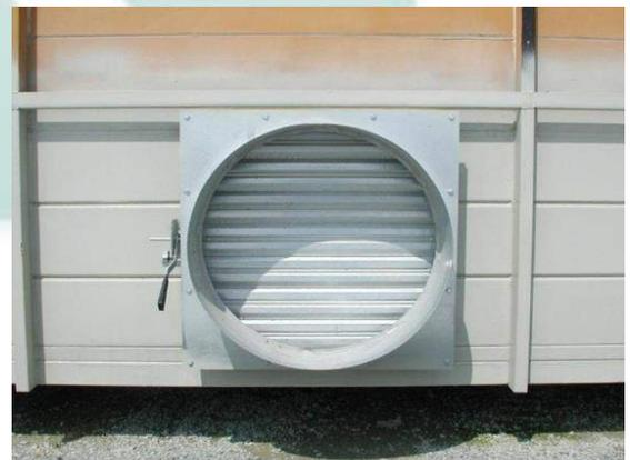
Apertura di areazione dotata di lamelle di chiusura con motore modulare. Apertura e chiusura automatica all'inizio e al termine dell'essiccazione.
