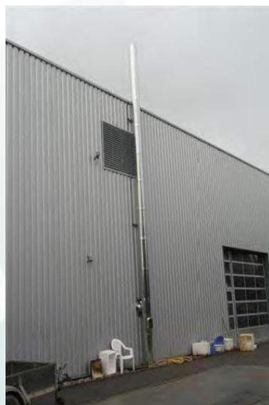
Aspirazione di aria fresca da un canale centrale attraverso un'apertura di areazione con una griglia nel muro esterno.
