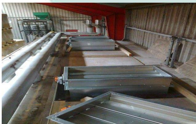
Parte superiore di un impianto di essiccazione esistente; installazione degli aeratori a lamelle per l'aria secca.
