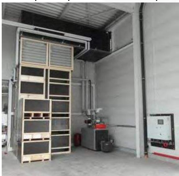
Impianto di essiccazione per due sezioni con riscaldamento centralizzato.
