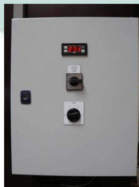
Controllo del riscaldamento tramite termostato di modulazione e un controllo a 5 velocità.
