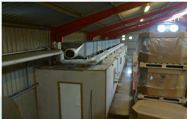
Impianto di essiccazione dopo la modifica; una condotta centrale con aeratori a lamelle per ciascuna fila/sezione.
