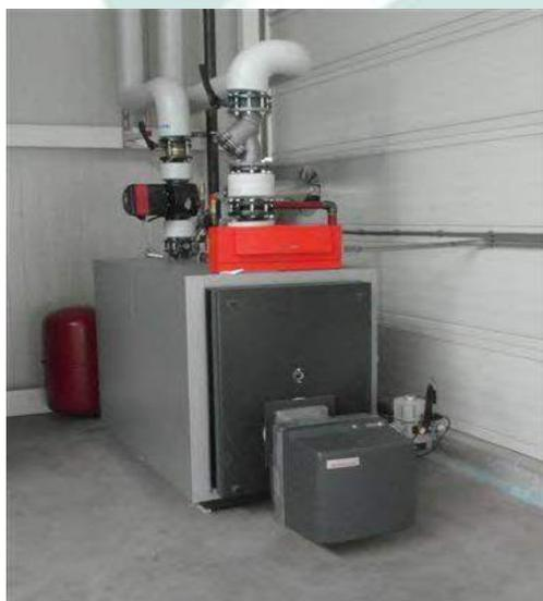
Esempio di boiler per il riscaldamento centralizzato di due sezioni.
