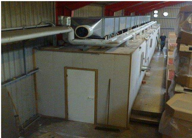
Anche gli impianti di essiccazione esistenti possono essere dotati di una condotta di suddivisione dell'aria secca. L'aria secca si miscela nella condotta di aspirazione con l'aria esterna per poterla portare ad un contenuto di umidità più basso desiderato.
