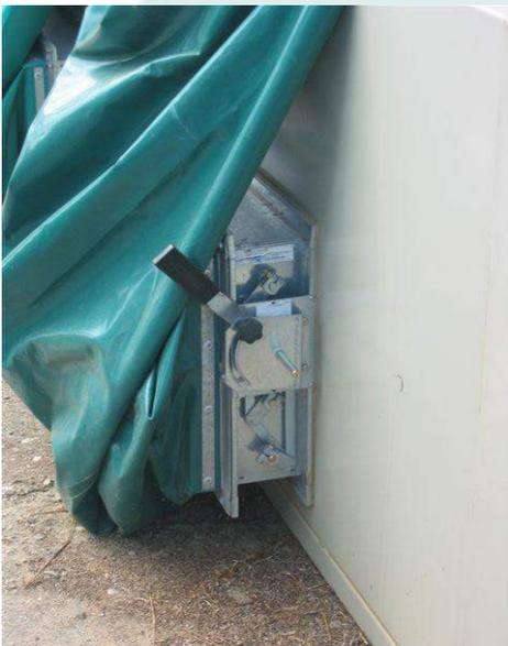
Le volet d'entrée ou le clapet d'admission d'air est équipé d'un moteur
