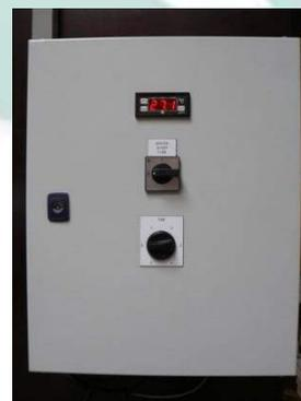
Régulation chauffage par thermostat modulaire et ventilateur en 5 vitesses.
