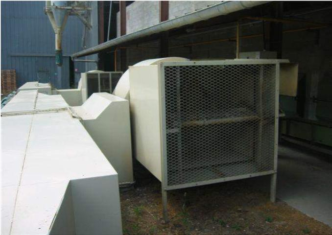
La capacité de chauffage est généralement variable. Un flow fan est placé sur le côté de l'aspiration du ventilateur et le chauffage. Le flow fan contrôle la capacité du ventilateur.
