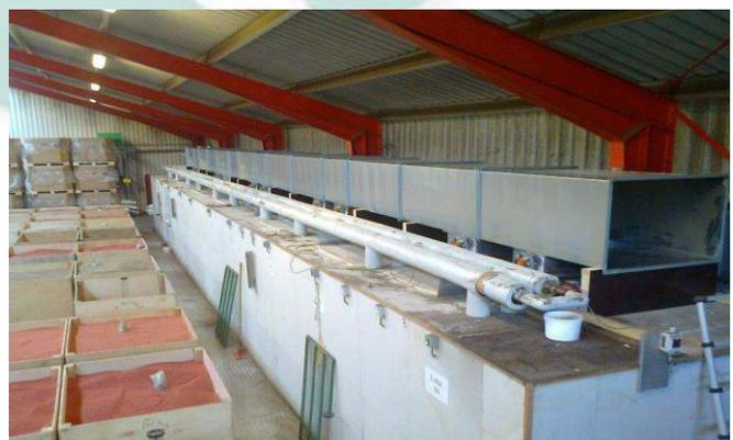
Canal de répartition d'air sur les volets d'admission. L'air séché du déshumidificateur va vers chaque section.
