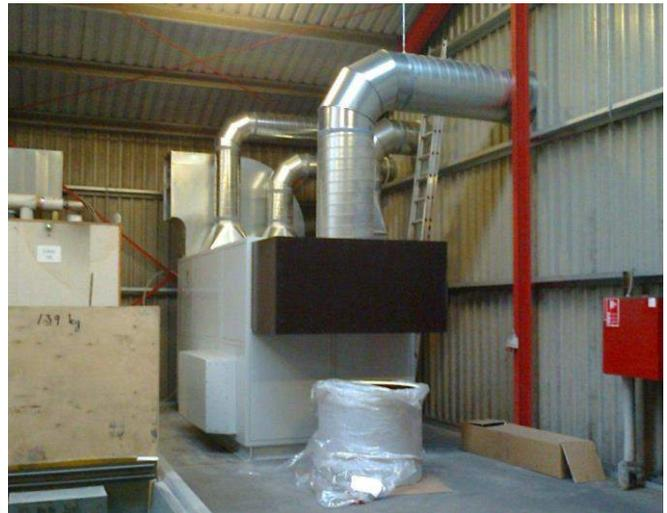
Le déshumidificateur d'air par absorption.
