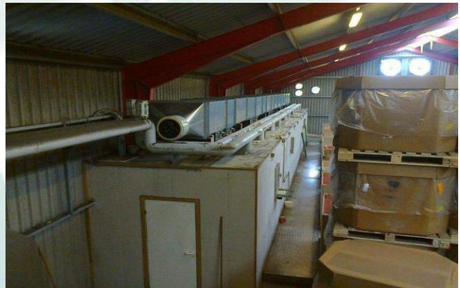
Installation après transformation; un canal central avec un jeu de volets par rangée / section.
