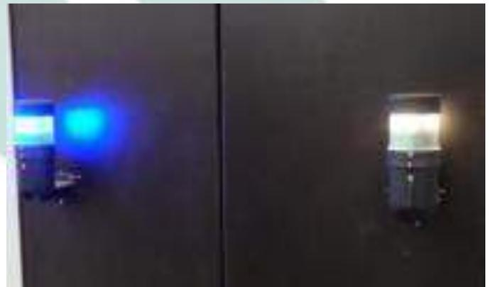
Des «LED» de couleurs indiquent pour chaque palox la phase de séchage; Orange = démarrage séchage; Bleu = dernière phase; Blanc = séchage terminé.
