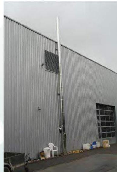
Aspiration de l'air frais à travers un canal central par une bouche d'aspiration grillagée dans le mur.
