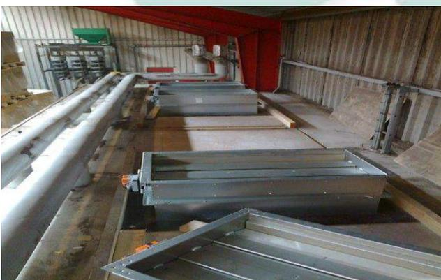
Vue de haut du séchoir existant; Installation des volets d'admission pour l'air séché.
