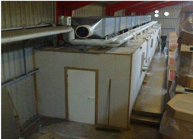
Auch bestehende Trockenanlagen können über einen Verteilkanal mit getrockneter Luft versorgt werden. Die getrocknete Luft mischt sich im Ansaugkanal mit der Außenluft, um diese auf den gewünschten geringeren Feuchtigkeitsgehalt zu bringen.
