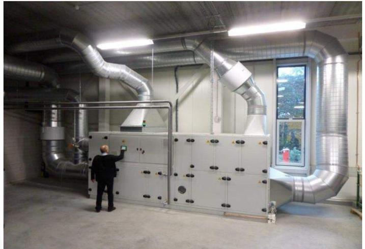
Agratechnik hat ein Verfahren entwickelt, bei dem ein zentraler Lufttrockner (1) die getrocknete Luft dorthin befördert, wo diese benötigt wird (1A). Konditionierungszellen (2), Trockentische (3), diverse Trocknungsanlagen (4, 5), Kabinettrockner (Statisch (6) oder Rotation (7)), oder Einpackmaschinen (8,9) werden an eine zentrale Luftleitung angeschlossen. Dank des fortschrittlichen ABC-Processors wird die getrocknete Luft automatisch dorthin abgegeben, wo zu diesem Zeitpunkt Bedarf besteht.
