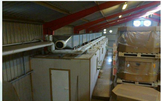
Trockenanlage nach der Anpassung; ein zentraler Kanal mit Jalousieklappe pro Reihe/Satz.
