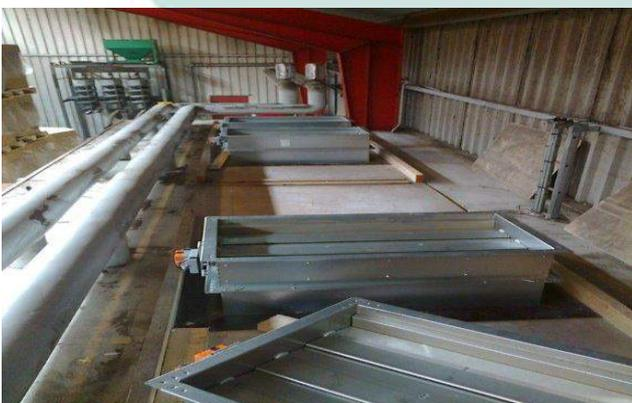
Oberseite einer bestehenden Trocknungsanlage; Installation von Jalousieklappen für getrocknete Luft.
