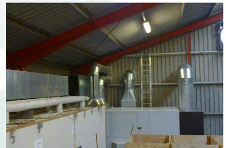
Die Luftleitung an neue Adsorption Luft Trockner zum Trocknen auf weniger feucht Inhalte des Saatgut.
