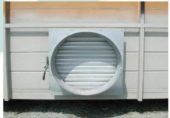
Vor die Zuluftöffnung wird ein modulierendes, motorgesteuertes Ventil installiert.
