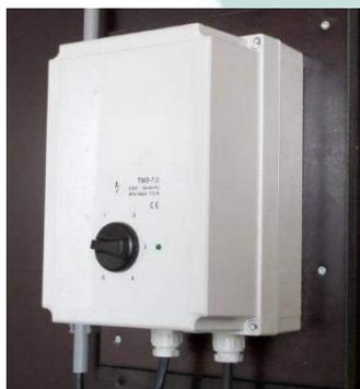
Gebläse mit 5-stufigem Geschwindigkeitsregler.
