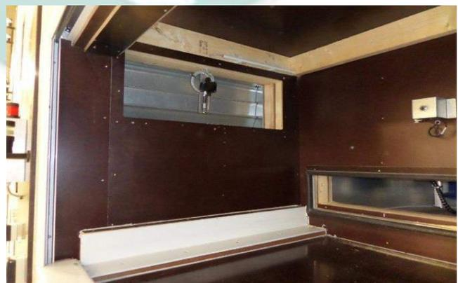
Auslass mit T°- und rF-Sensor zum Messen des Prozesses
