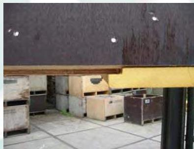
Unterschiedliche Stärke der Multiplex-Platte und der Hartholzplatte.
