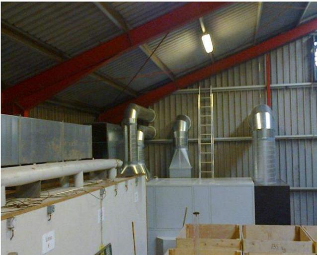
Der zentrale Lufttrockner wird am Luftkanal angeschlossen.
