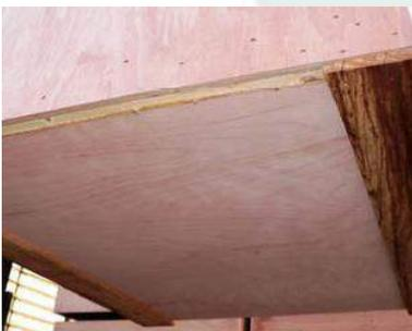
Der Kistenboden wird mit 9 mm Multiplex verschlossen.
