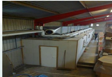
Neue Luftleitung am Trockner zu verteilen getrocknete Luft pro Abschnitt.
