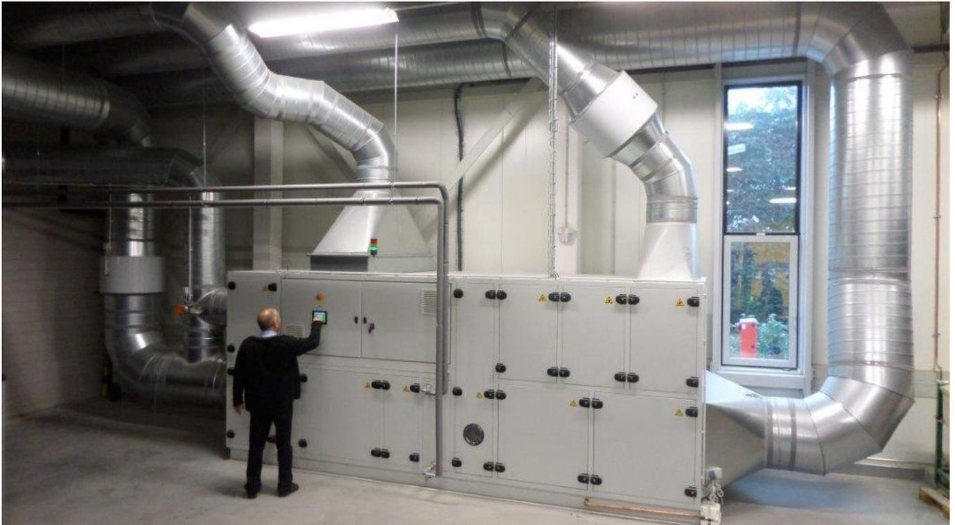
Entfeuchtete Luft, durch Absorption oder spezielle Hybridtrockner.
