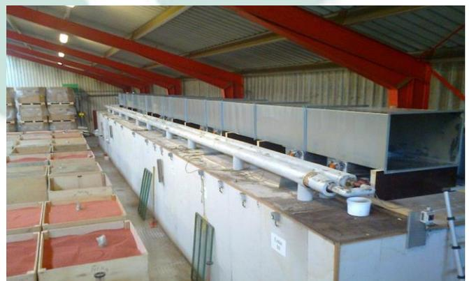
Luftverteilkanal oben auf den Jalousieklappen. Getrocknete Luft aus dem Lufttrockner zu jedem Abschnitt.
