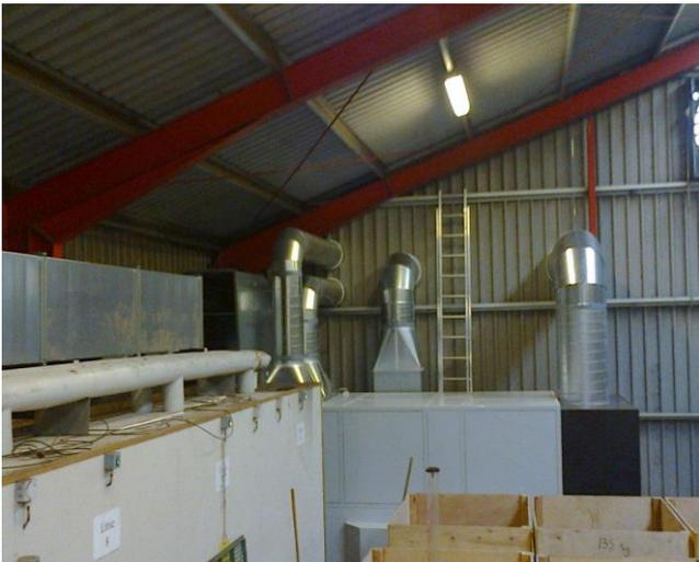
Der zentrale Lufttrockner wird am Luftkanal angeschlossen.
