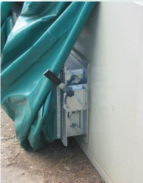
Abluftklappen oder Schieber werden mit einem Motor ausgerüstet.
